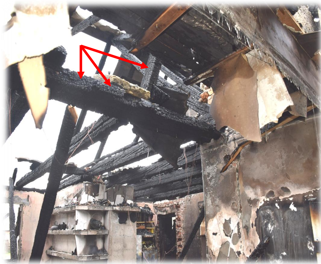
Na stropnim drvenim gredama se ocrtaava uzorak tzv. „krokodilske kože” .
