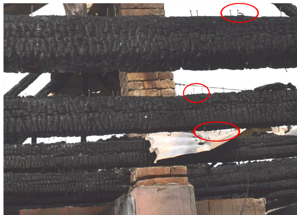
Na gredama se vide čavli kojima su podne i stropne daske bile učvršćene za grede.
