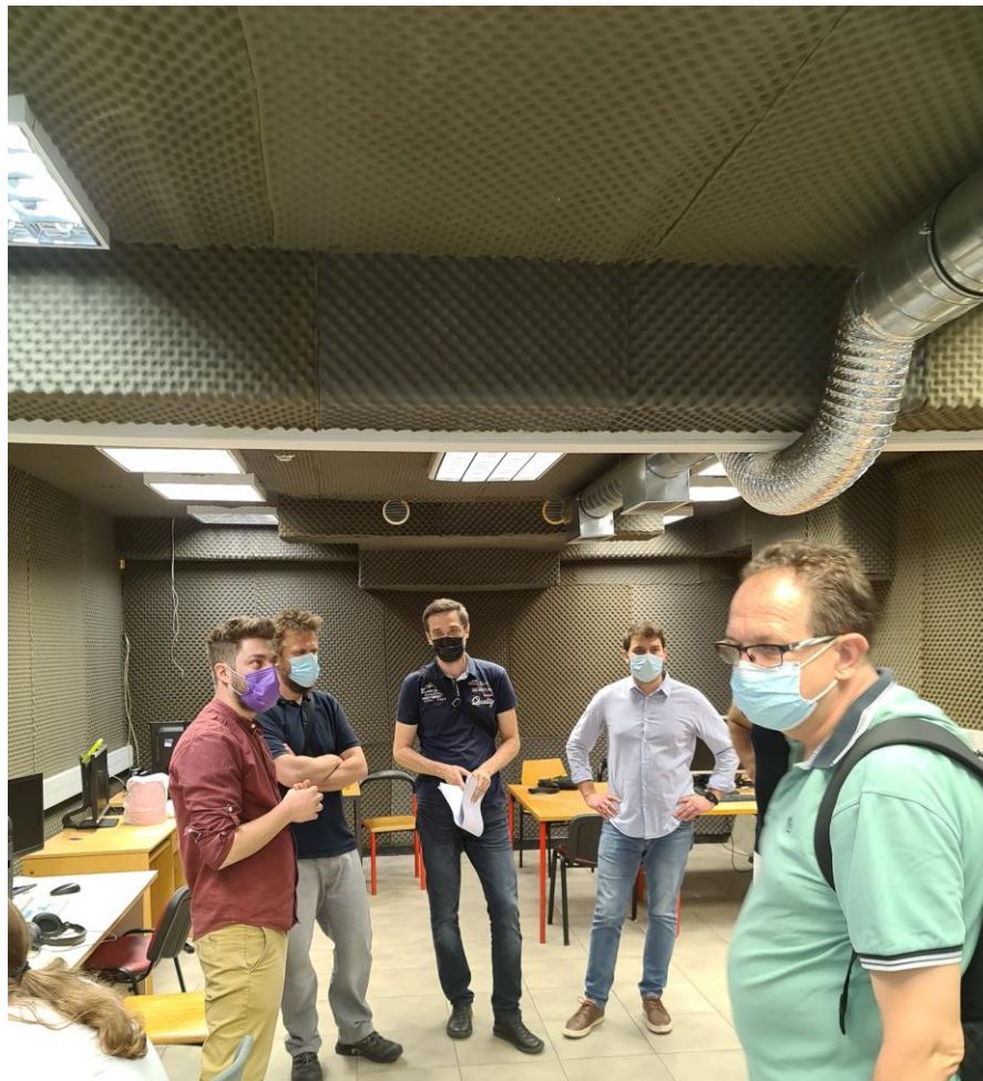
Slika: prostor studija u podrumu u potpunosti obložen gorivim spužvastim materijalima
